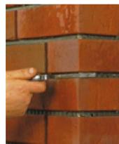
Lisser les joints au moyen d'un fer à joints. Les briquettes sont ainsi entourées de colle ; il convient d'éviter un passage ultérieur avec de l'eau jusqu'au jointoiment définitif. Cette méthode permet en outre d'obtenir une profondeur de joints régulière et suffisante (profondeur de joints > épaisseur de briquettes). Éliminer les éventuelles salissures au moyen d'une éponge.
