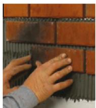
Coller en appuyant fortement les briquettes selon un mouvement horizontal. Veiller à éviter la formation de cavités ! Poser les briquettes dans l'intervalle. Une vérification visuelle permet de rectifier les joints.
