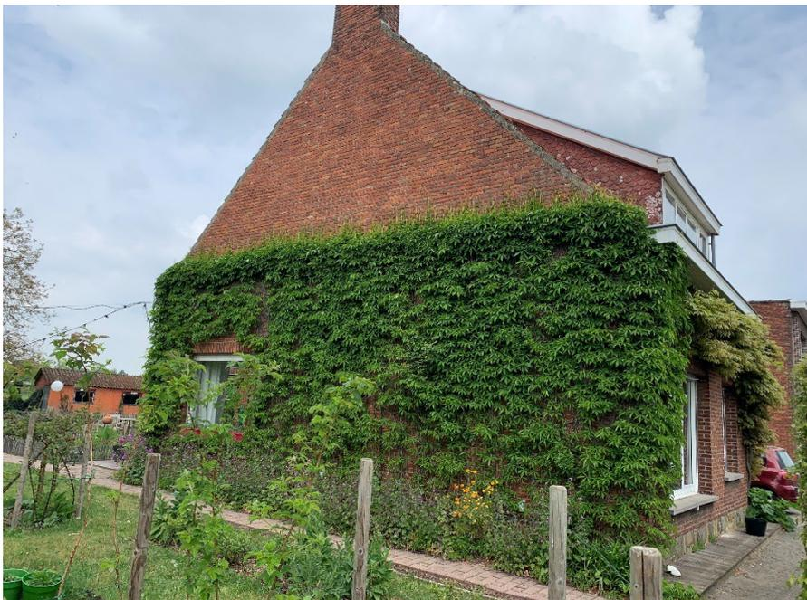
Végétation, dégâts causés par le gel, joint sur sablon ou sable fin
