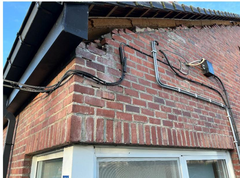
Dégâts causés par le gel et creux ouvert à la jonction avec le toit
