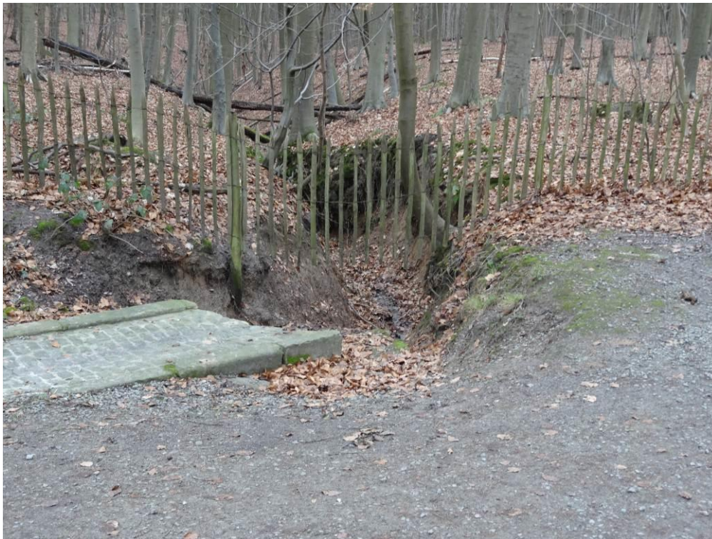
Photo 20 – Arrivée des eaux de ruissellement de la voirie communale
