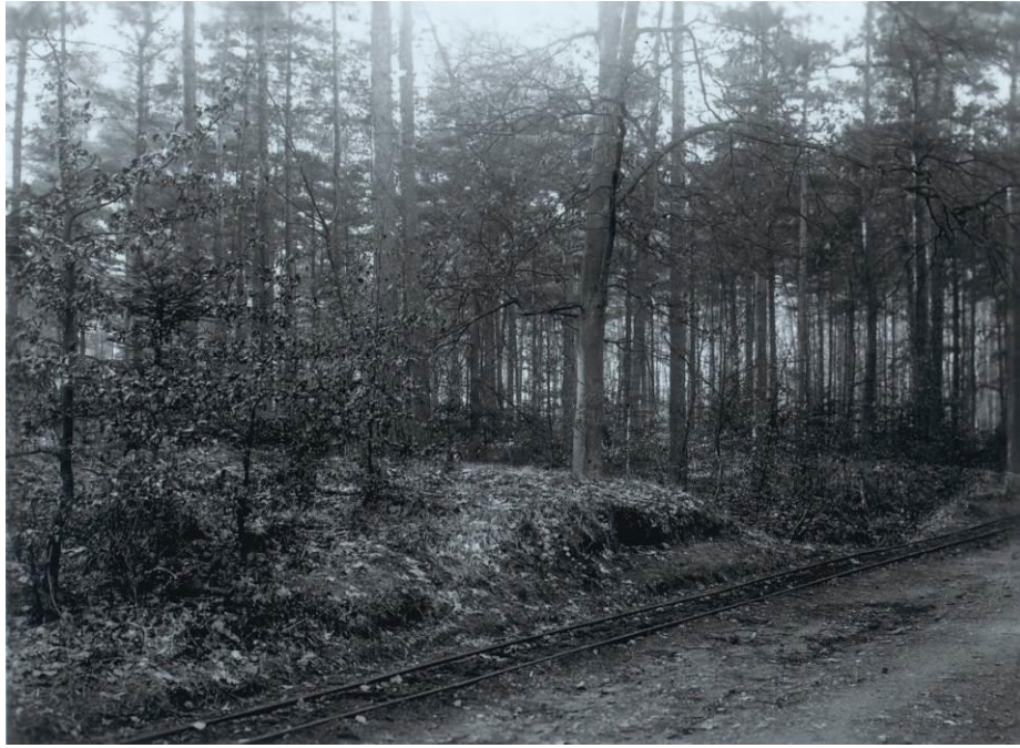
Photo 1 – Vue partielle des fossés et levées de terre et du chemin de fer Decauville vers 1935 4
