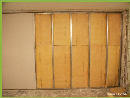
**Le principe de l'isolation « M-R-M » : les parois doubles sur ossatures légères**
