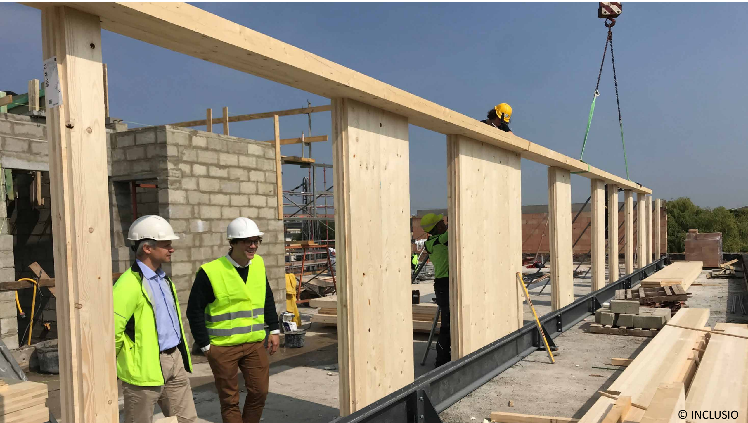
Façade en bois (CLT) du 4ème étage
