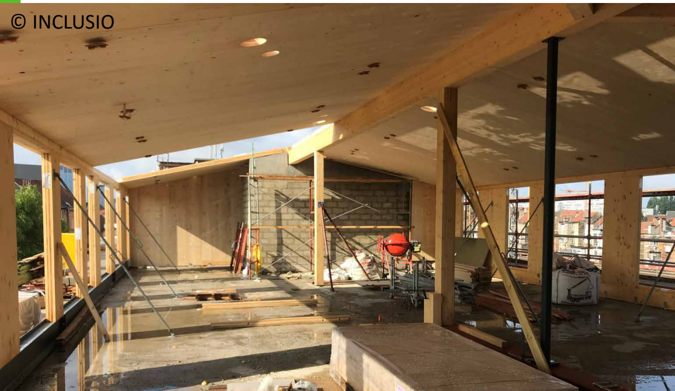
Structure en bois (CLT) du 4ème étage
