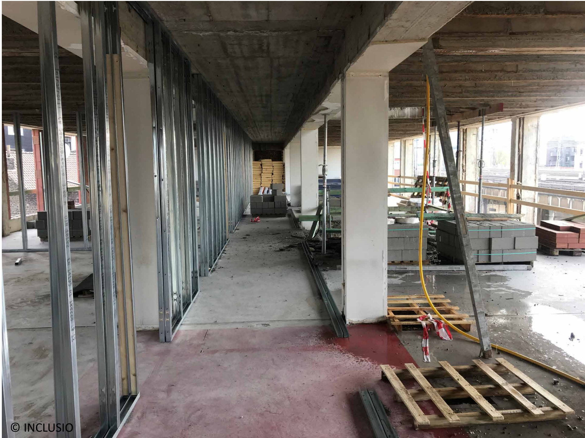
Couloir pendant le chantier – nouvelle structure légère
