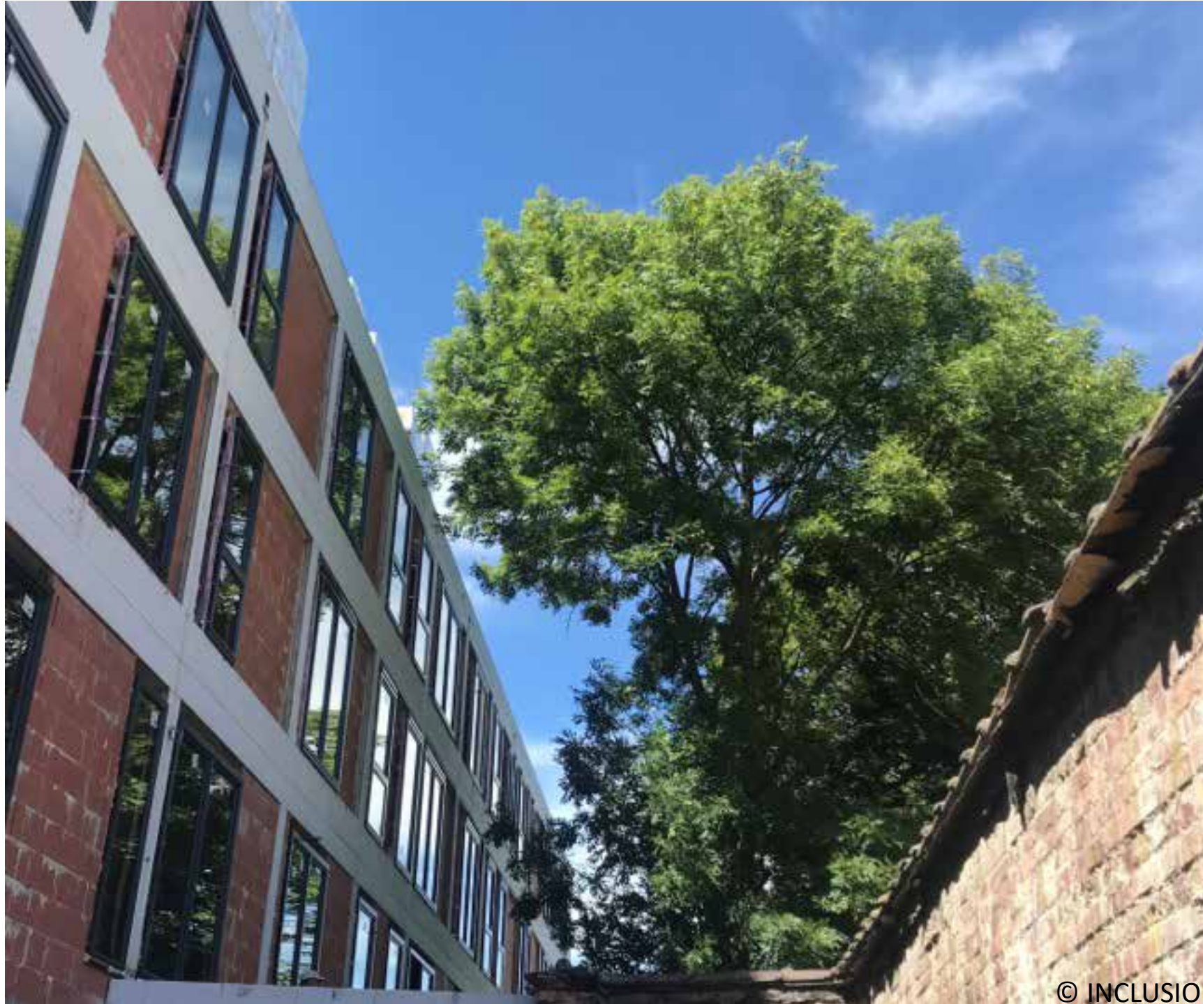
Nouvelle cour à l'arrière pour les asbl du Rez
