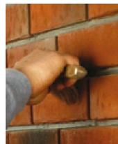
Balayer les joints après séchage complet du mortier colle.
