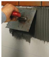
Appliquer le mortier colle StoColl KM FR sur toute la surface et peigner à la verticale au moyen de la truelle crantée 10 x 10. N'appliquer que la quantité de mortier strictement nécessaire sur le moment. Éviter la formation d'une pellicule.
