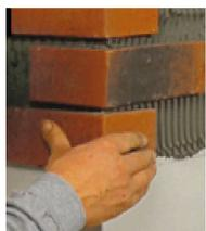
Coller les briquettes si possible de haut vers le bas et à partir de l'angle du bâtiment.
