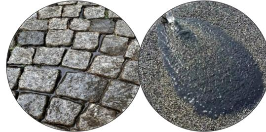
Pavés à joints perméables OU
