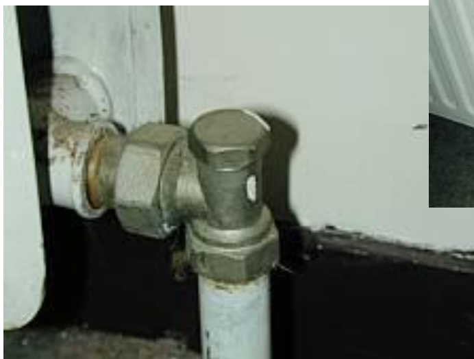
Té de réglage du débit d'un radiateur
