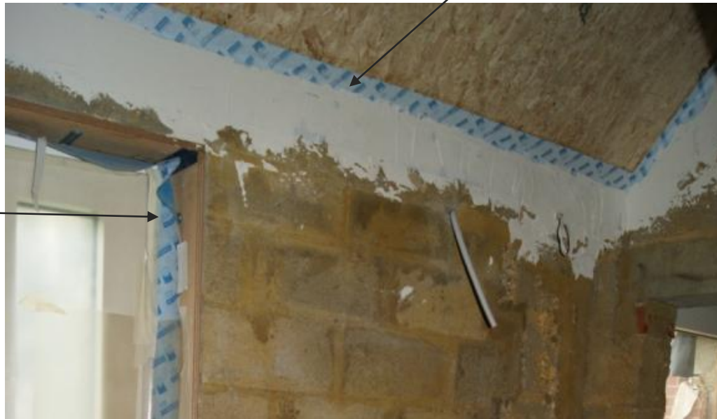
Raccord toiture – façade
