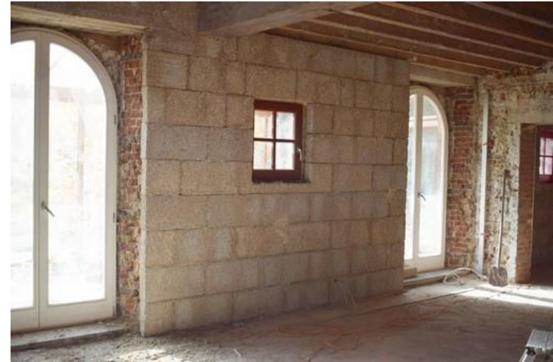
Isolation intérieure à base de bloc de chanvre
