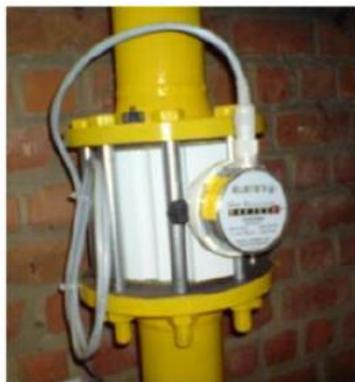
$\Sigma P \text{ chaudières} \geq 500 \text{ kW} \rightarrow$  compteur de combustible + compteur énergie
