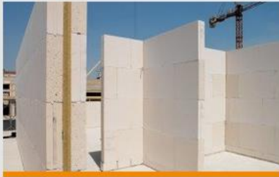
Dispositif | Double mur massif et acoustique
