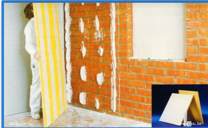
Les doublages de type A sont constitués d'éléments manufacturés où l'absorbant est collé à la plaque de finition, constituant ainsi des doublages thermo-acoustiques.
