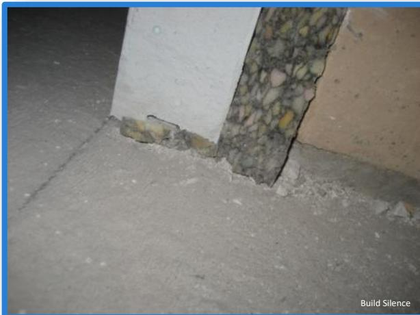
Le mur est désolidarisé de la structure sur ses quatre faces au moyen de dispositifs de désolidarisation adéquats.
