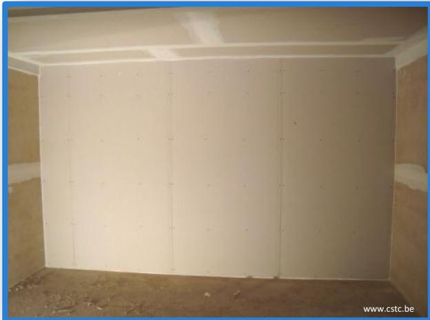
Les doublages de type B sont constitués d'une ossature indépendante (profilés ressorts, profilés métalliques, ossature bois décollée) de la paroi de base.
