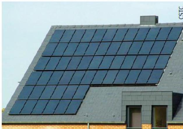
Fig. 10 Capteurs solaires photovoltaïques en semi-intégration.
