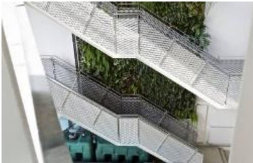
Mur végétal non productif
