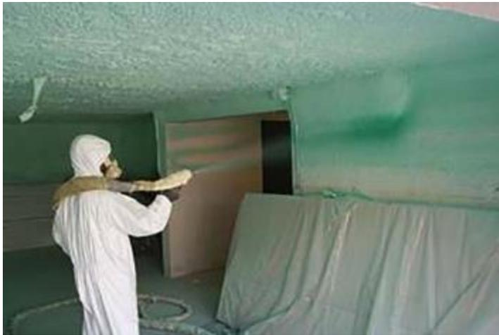
Protection intégrale lors de la mise en œuvre par projection d'un isolant thermique
