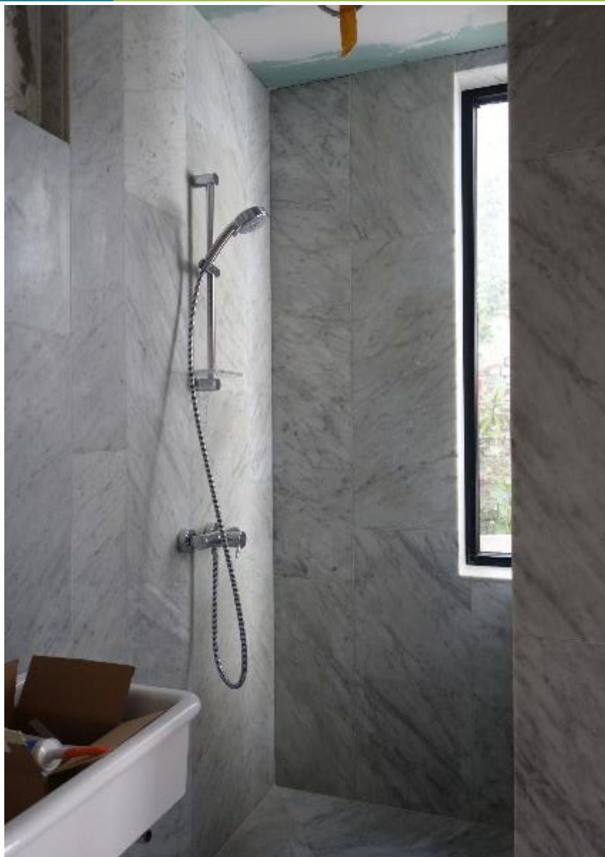
Salle d'eau et douche à l'italienne au rez-de-chaussée
